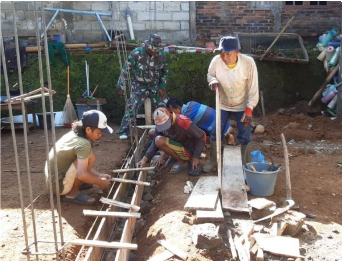
Pemasangan Bekisting Balok Sloof
