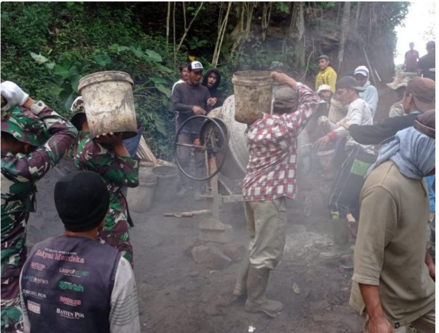
Pelansiran Matrial di Lokasi TMMD
