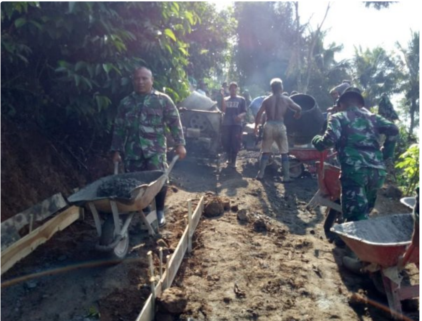
Satgas TMMD Kebut Pengecoran Jalan
